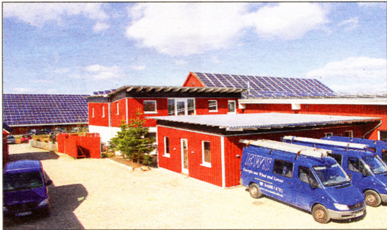
Die neuen Gebäude bei EWS wurden am Tag der offenen Tür eingeweiht. Foto: ews
