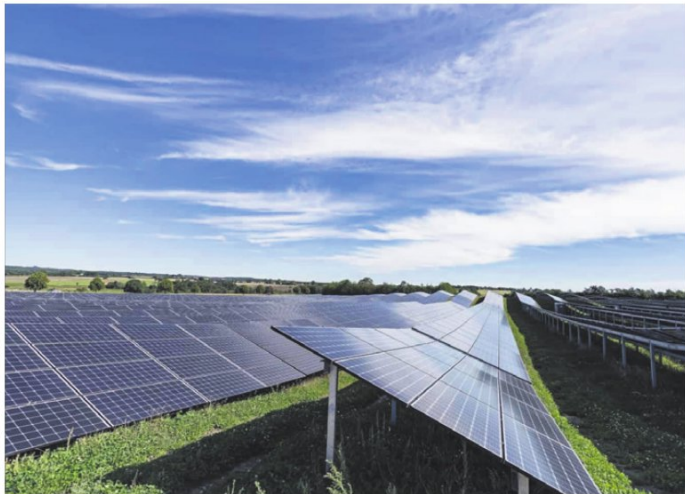
Også solcelleparker tager længere tid at opstille, når der mangler dele fra producenter i for eksempel Kina. Foto: Better Energy
