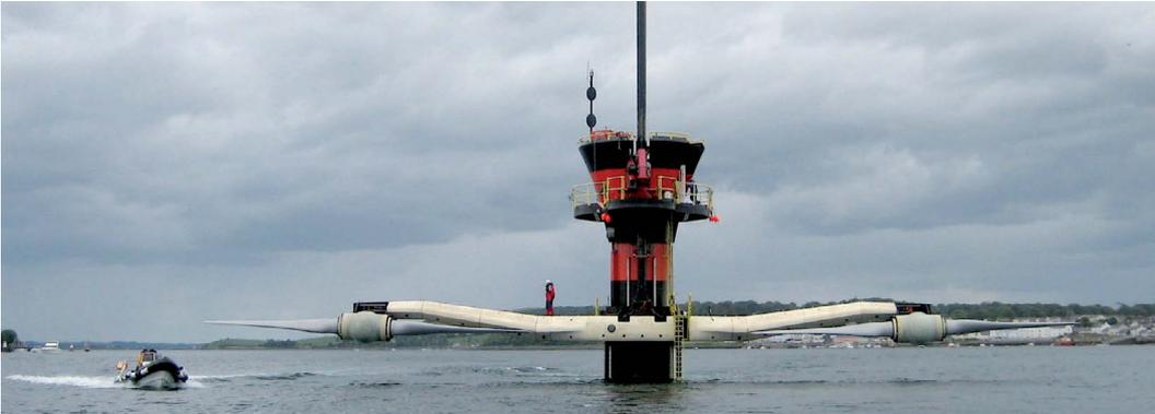
*Gezeitenströmungskraftwerk „SeaGen“, Leistung 1,2 MW
