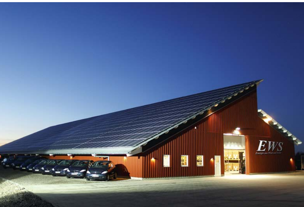
Reichlich Platz: Zwei solche Logistikgebäude bieten mehr als genug Umschlagfläche, bis zu den Umsatzeinbrüchen 2012 waren sie komplett ausgelastet.
