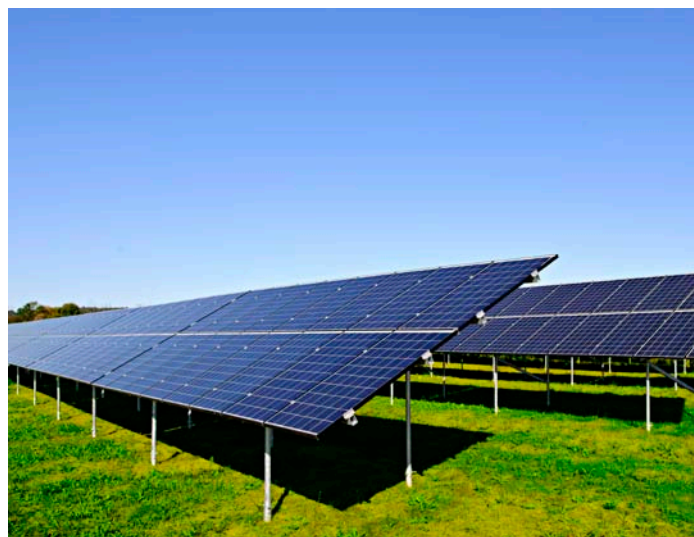
Fig. 3: Solaranlage nach der Reinigung
